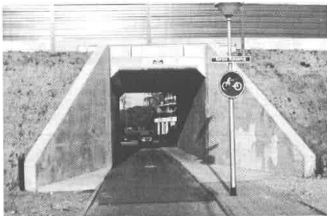
De vernieuwde tunnel aan de Heijersteeg
