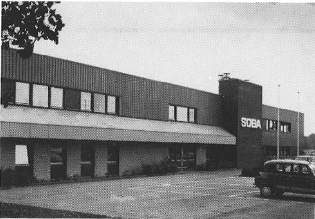
Bedrijfsgebouw van Soba, gelegen op kruispunt Nusterweg/Nolenslaan.
