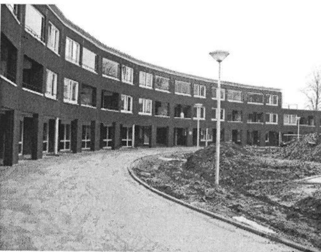
De Gelderhof met balkons en zicht op de kerk
