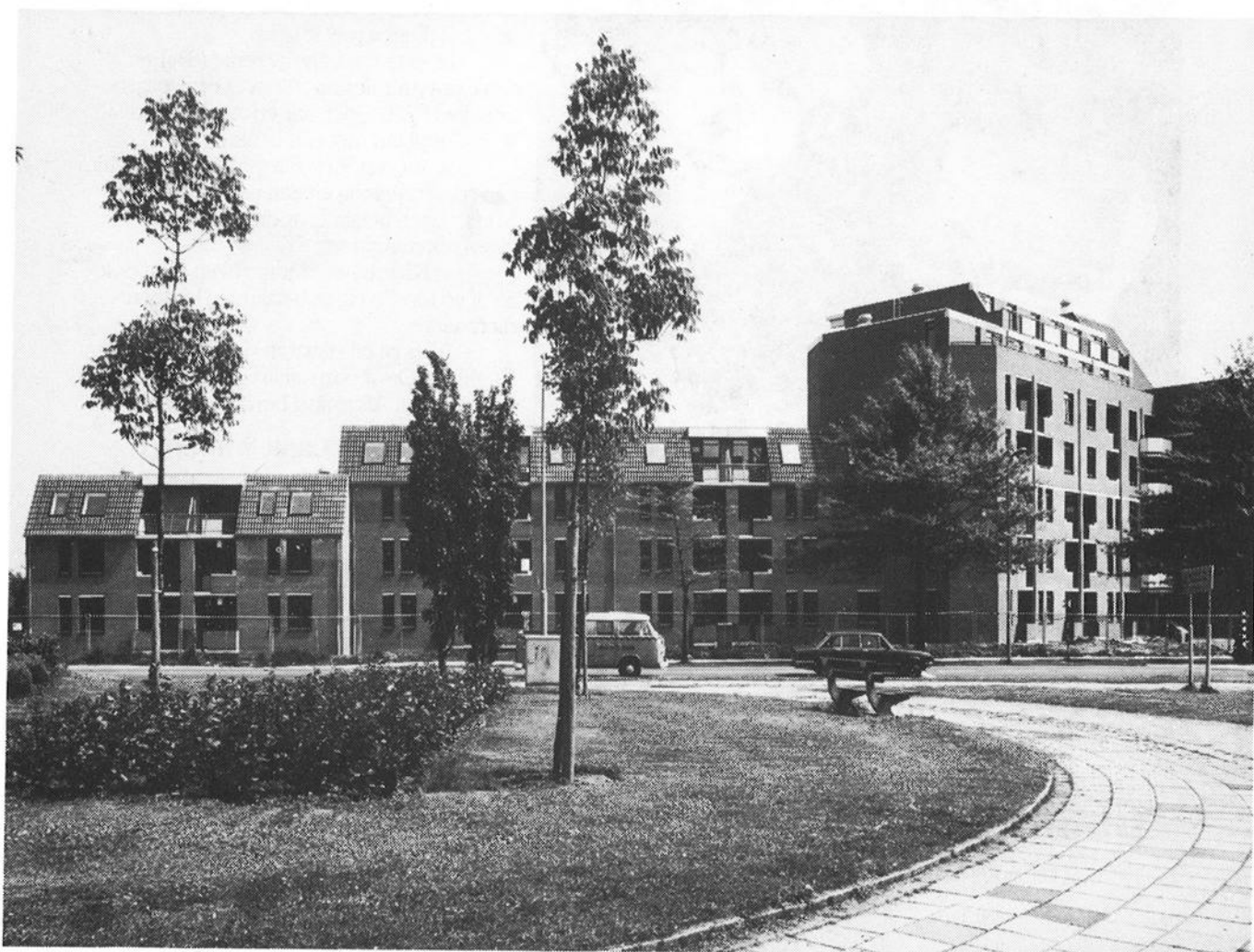
De Reinoud-flat, gezien vanaf de hoek Elisabeth van Barstraat - Rijksweg Noord.
