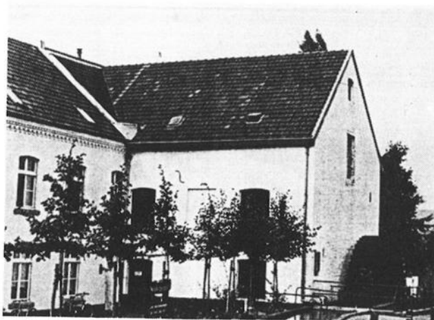
De watermolen na de restauratie (1990).
