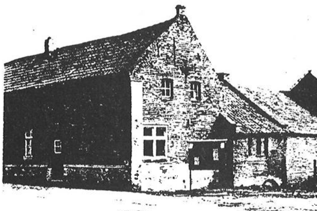
De voorzijde van de "Armenmolen" na de stillegging. Rechts van het publikatiebord het turbinegebouw.
