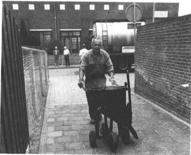
Transport Gietasfalt naar gymzaal Foto: Frans Dieteren
